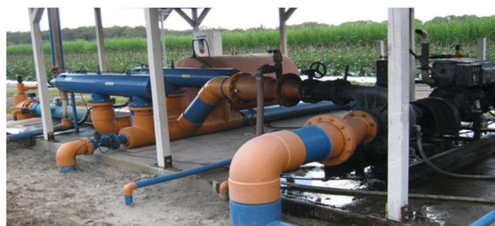
Figura 1. Vista panorámica de un cabezal central de riego por goteo/ Panoramic view of a drip irrigation pump station.
