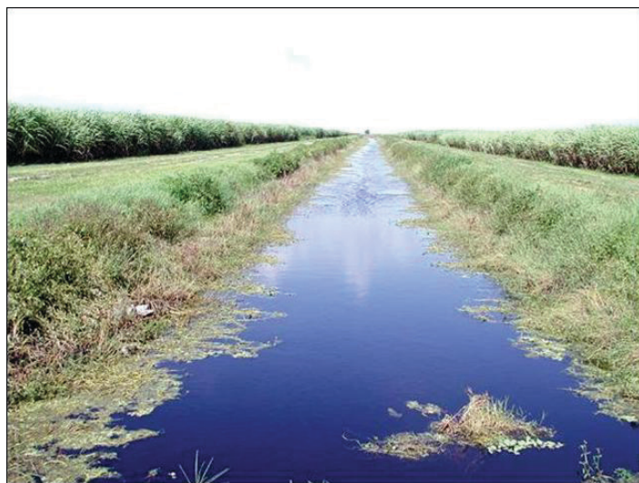
Figura 10. Estabilización de los bancos de los canales con vegetación.
