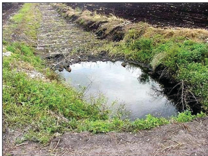
Figura 5. Típico colector de sedimento en una zanja de campo.
