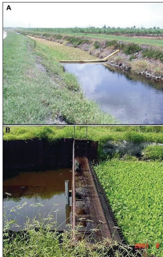
Figura 11. Las barreras de retención (a) y los retenedores de basura (b) mantienen malezas acuáticas y otros materiales orgánicos lejos de las bombas de drenaje.
