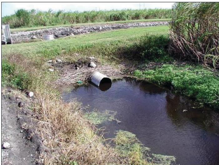
Figura 9. Los tubos de drenaje instalados por encima del fondo de las zanjias de campo reduce el transporte de sedimentos.
