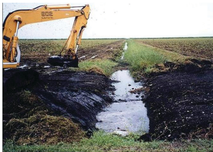
Figura 6. Limpieza de suelos y sedimentos acumulados en zanjias de campo.
