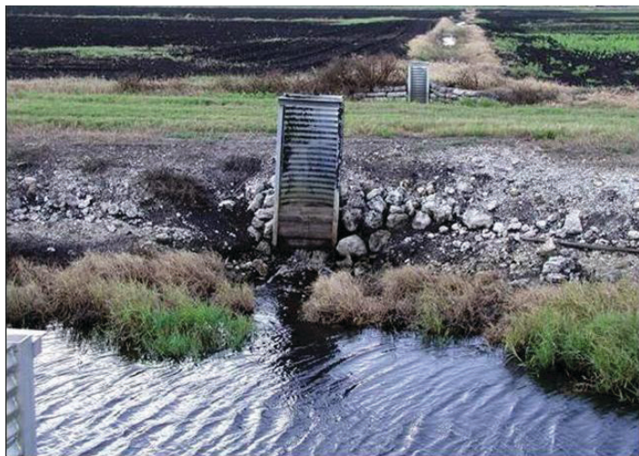
Figura 7. El uso de tableros en canales de drenaje verticales reduce el drenaje en campos cercanos a las estaciones de drenaje.
